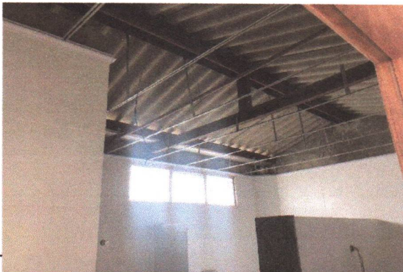
INSTALAÇÃO DO FORRO PVC NOS VESTIÁRIOS DA ACADEMIA
