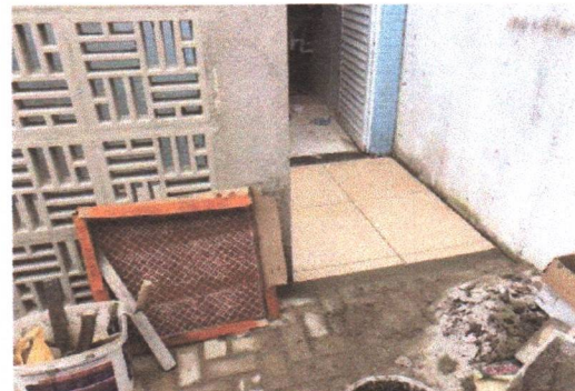
INSTALAÇÃO DO REVESTIMENTO DAS RAMPAS DOS VESTIÁRIOS DAS QUADRAS
