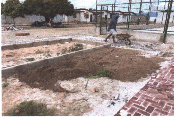
ATERRO DO CANTEIRO PARA INSTALAÇÃO DO COBOGRAMA
