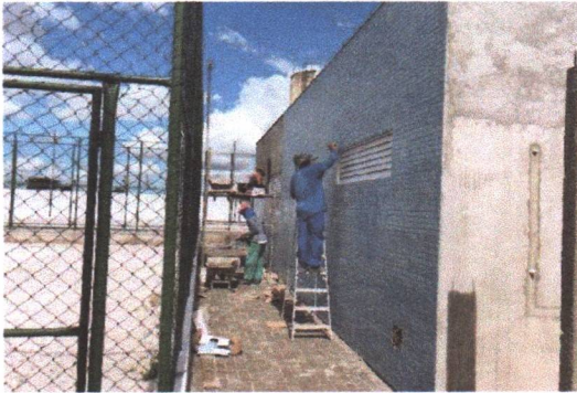
INSTALAÇÃO DO REVESTIMENTO CERÂMICO EXTERNO DOS VESTIÁRIOS DAS QUADRAS
