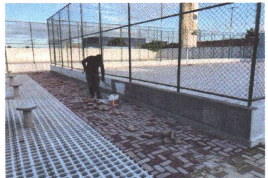
APLICAÇÃO DO SELADOR NAS MURETAS DAS QUADRAS
