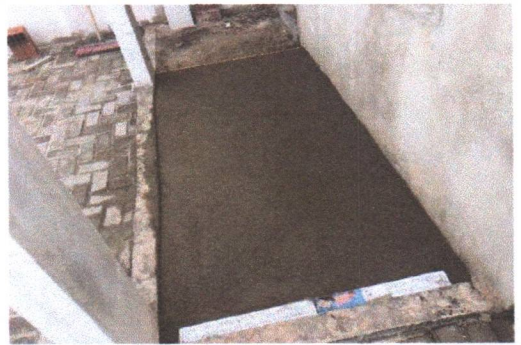
CONCRETAGEM DOS PISOS DOS CHUVEIRÕES
