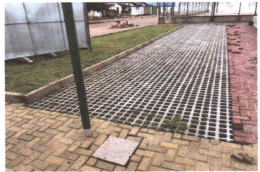
INSTALAÇÃO DO COBOGRAMA
