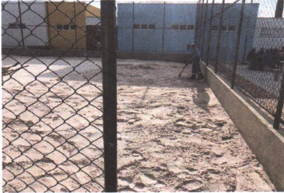
ESPALHAMENTO E NIVELAMENTO DAS AREIAS DAS QUADRAS
