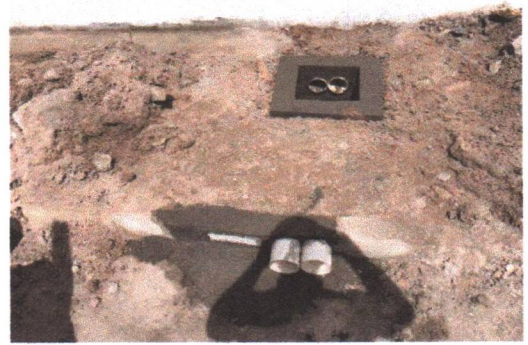
CONFECÇÃO DE CAIXA DE PASSAGEM DE ÁGUA PLUVIAL
