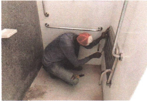
INSTALAÇÃO DOS BANCOS DOS VESTIÁRIOS
