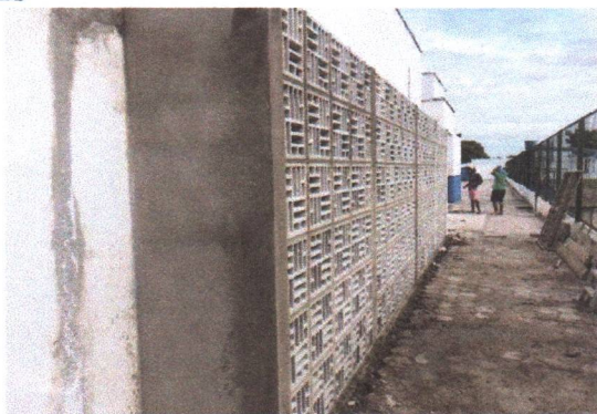
INSTALAÇÃO DOS COBOGÓS AO REDOR DA ACADEMIA
