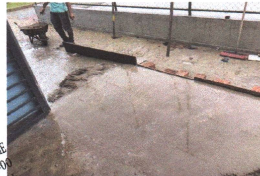
CONCRETAGEM DA RAMPA DE ACESSO AO HALL DE ENTRADA
