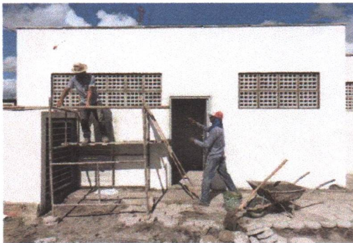
INSTALAÇÃO DOS COBOGÓS NAS JANELAS DO CORREDOR E DOS DEPÓSITOS
