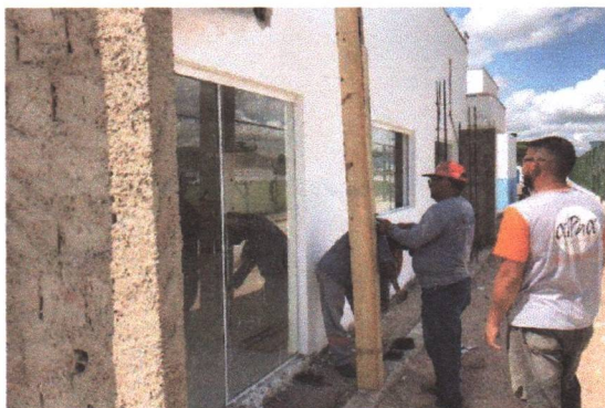
CAIXARIA DOS PILARES DOS COBOGÓS
