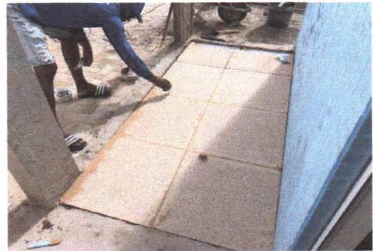
INSTALAÇÃO DO PISO CERÂMICO NOS CHUVEIRÕES DOS VESTIÁRIOS DAS QUADRAS
