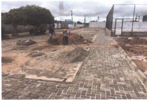
ATERRO DO CANTEIRO DO JARDIM PARA APLICAÇÃO DA GRAMA
